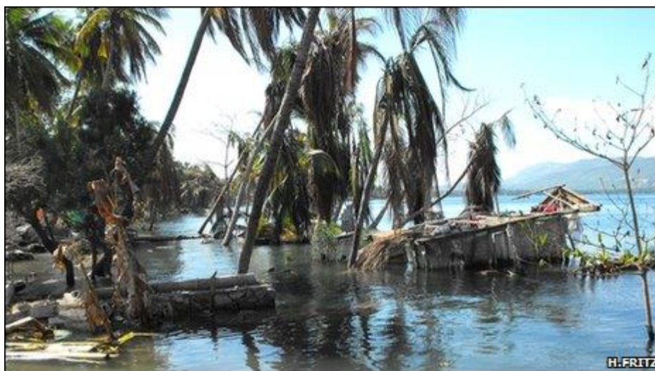
Foto 5. Efectos del tsunami causado por terremoto de Haití del 2010 (Fritz, 2010), mostrando daños a la edificación
