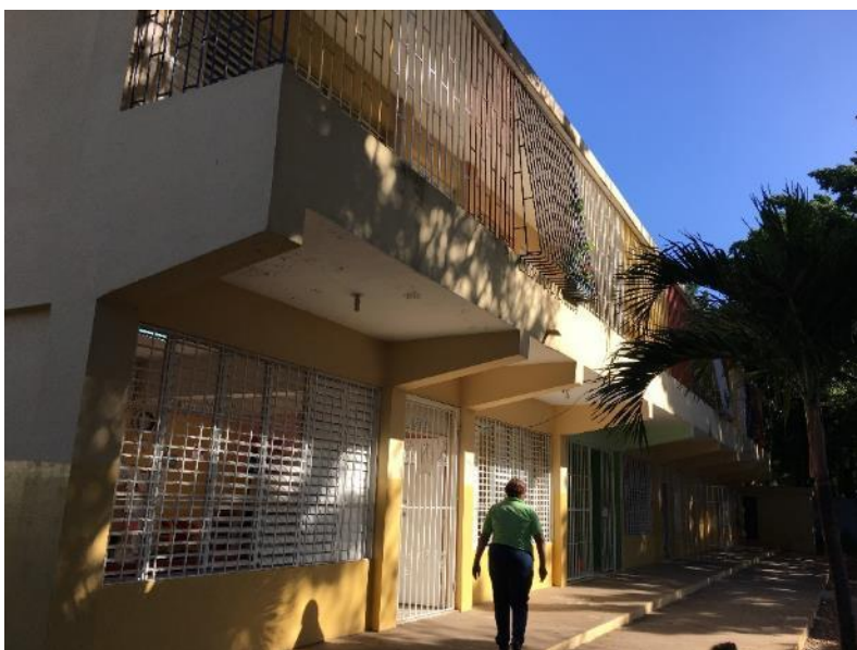
Foto 9. Escuela General Antonio Duvergé, construida en 1962
