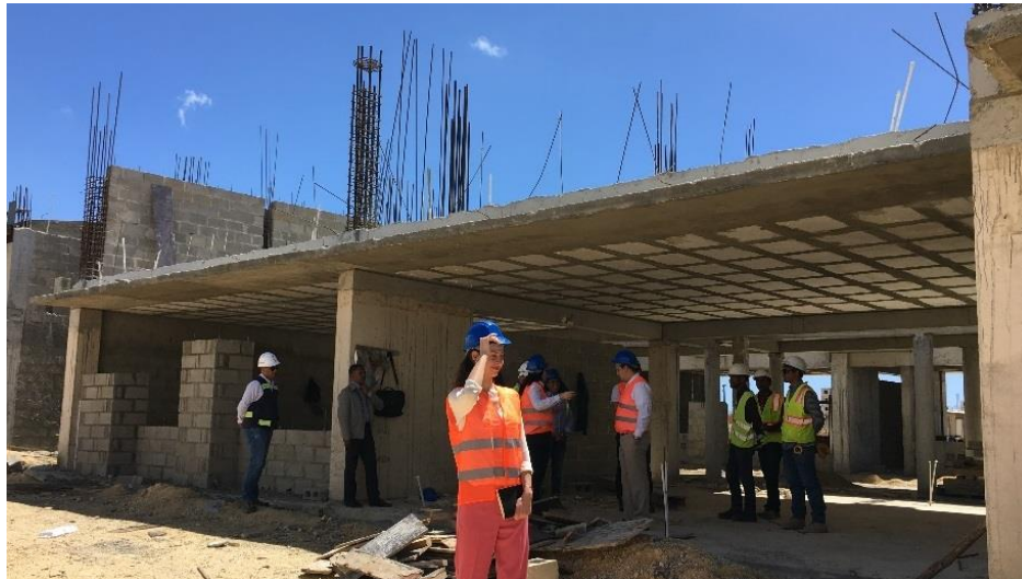
Foto 29. Losa aligerada diseñada bidireccional con viga de borde faltante, haciendo trabajar la losa en una sola dirección. Centro Educativo Juan Bosch 1
