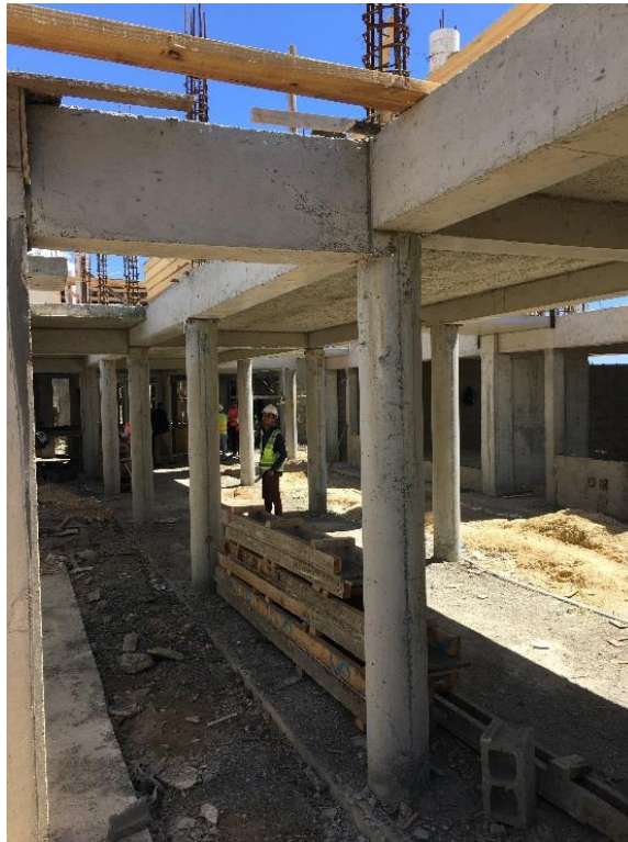
Foto 29. Losa aligerada diseñada bidireccional con viga de borde faltante, haciendo trabajar la losa en una sola dirección. Centro Educativo Juan Bosch 1
