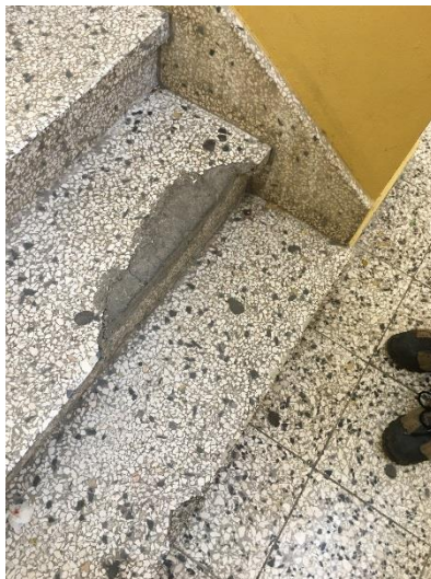
Foto 27. Elementos deteriorados por falta de mantenimiento. Escuela Fidel Ferrer
