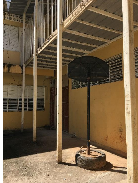
Foto 26. Centro Educativo de Educación Especial Santo Domingo - Pasillo en la ruta de evacuación, construido para unir dos secciones de la escuela sin criterios de seguridad o diseño sismo-resistente, o contra incendios.
