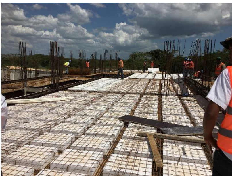
Foto 3. Centro Educativo Ciudad Juan Bosch 2, en construcción, que muestra la construcción en hormigón armado
