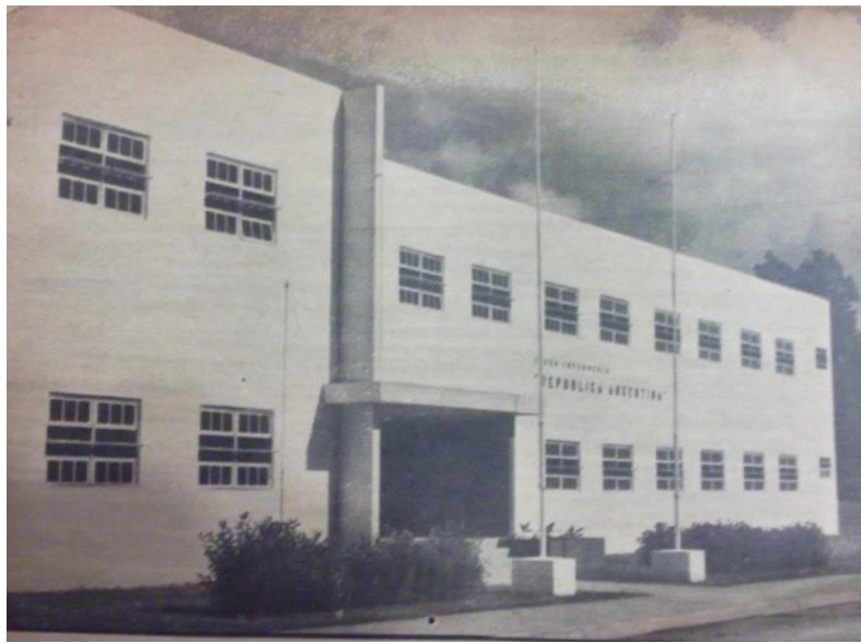
Foto 11. Escuela Original República de Argentina construida en la década del cuarenta. Fuente: OCI
