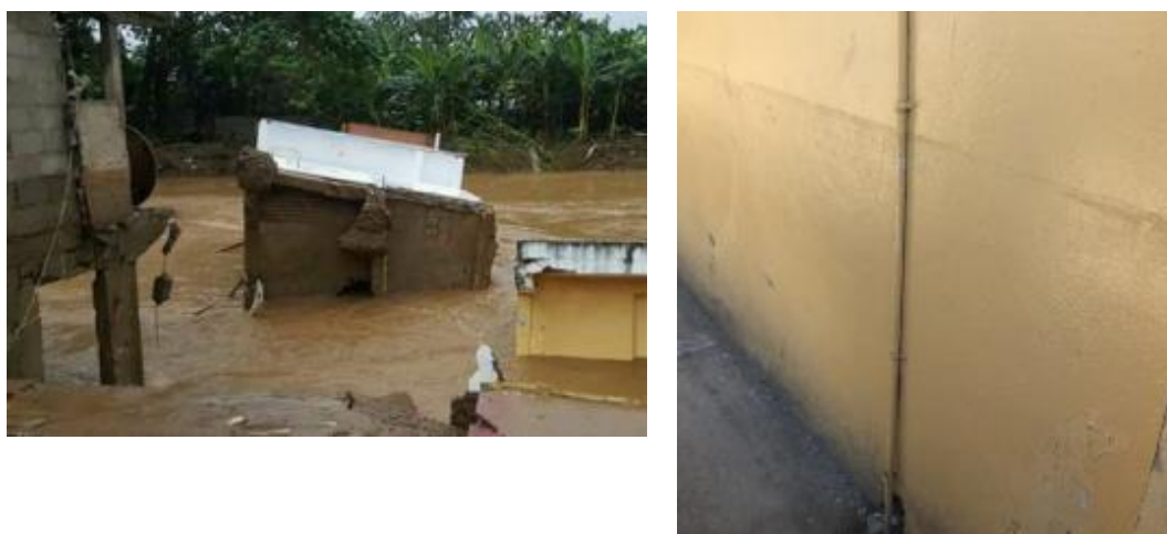
Foto 7. Inundaciones en República Dominicana. Fuente: Diario Avance y Arup, mostrando a la izquierda el colapso de un edificio y a la derecha el nivel (línea gris) de la inundación
