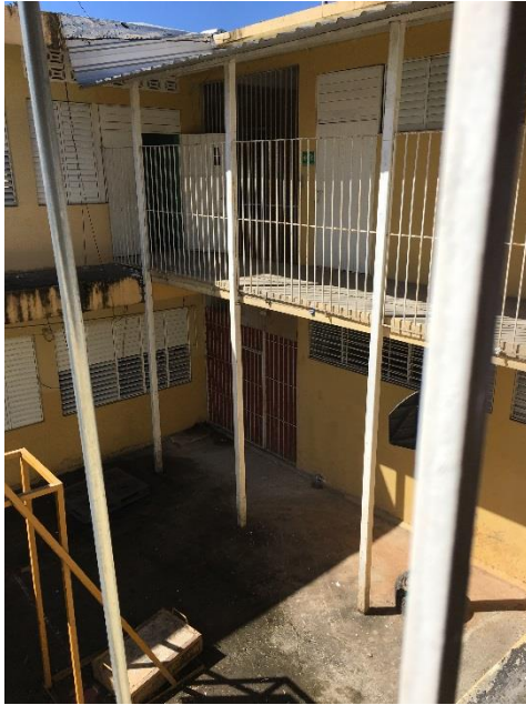
Foto 26. Centro Educativo de Educación Especial Santo Domingo - Pasillo en la ruta de evacuación, construido para unir dos secciones de la escuela sin criterios de seguridad o diseño sismo-resistente, o contra incendios.
